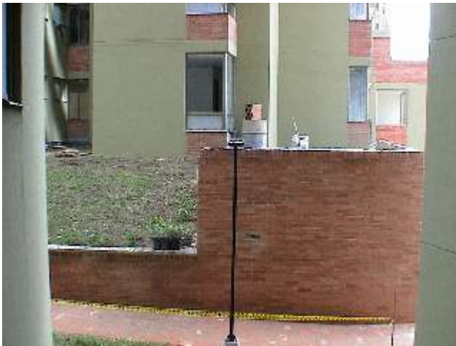
Estado actual muro entre torre 1 y 2
