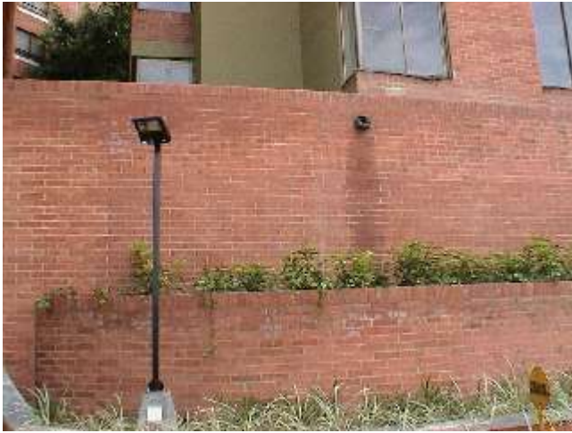
Vista actual frontal del muro jardinera torre 2
